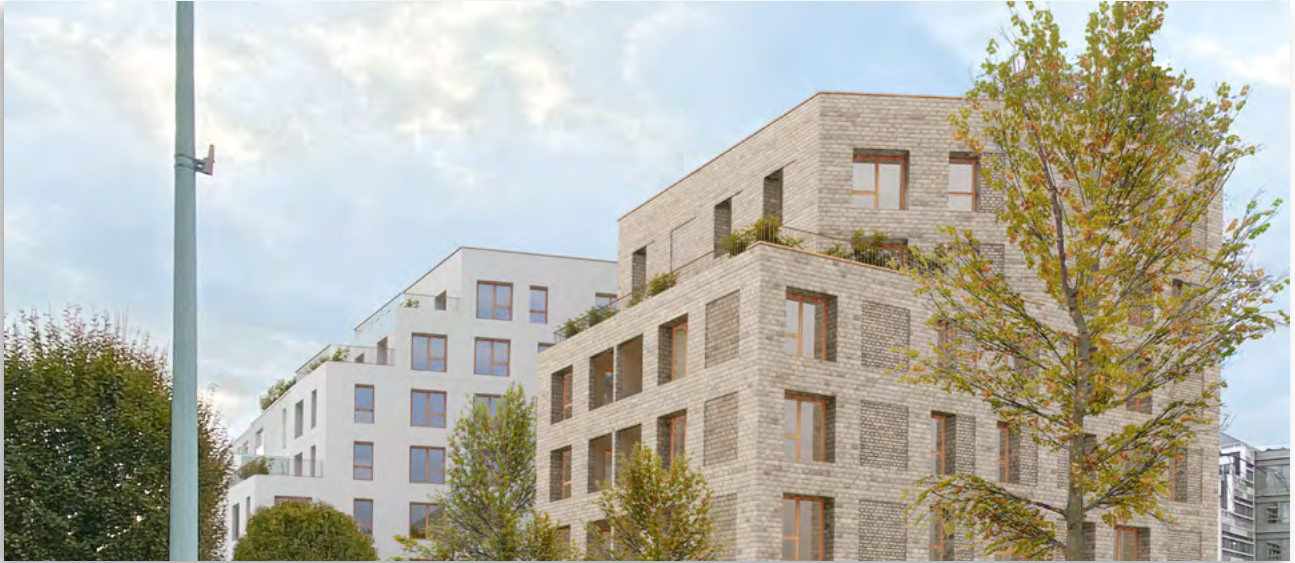
111, avenue Raspail, Gentilly (94) Architecte Cabinet ITAR
