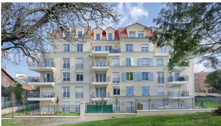
Sannois, 27 logements intermédiaires
