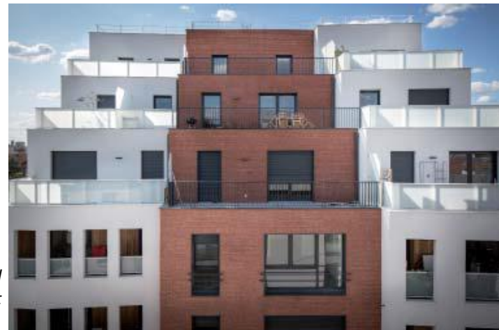
April 2019, Montreuil rue Edouard-Vaillant
